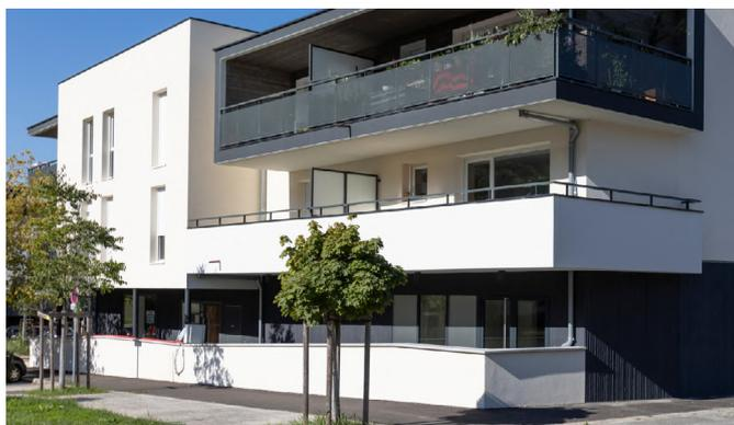
Murs déflecteurs permettant de canaliser les écoulements et de protéger les ouvertures (ici à Eybens et Murianette)
