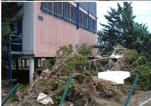
Construction sur pilotis du transformateur THT de Trans-en-Provence épargné par les inondations du Var en juin 2010
