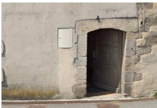
A Quimperlé, avec l'appui de la Ville, GRDF a réalisé de manière coordonnée l'adaptation des compteurs de gaz sur 50 bâtiments existants exposés aux crues de la Laita. L'adaptation consiste idéalement à remonter les compteurs ou, quand cela n'est pas possible, à installer une prise d'air ou évent surélevé.
