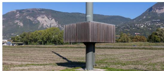
Surélévation des équipements sensibles d'une antenne relais
