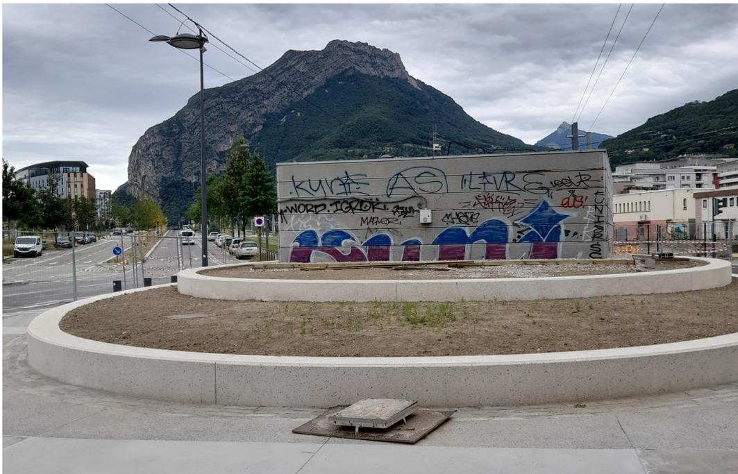
Défecteur devant un transformateur GreenAlp place de Sfax à Grenoble, dans l'axe d'écoulement de la rue Félix Escarglon en cas de brèche dans la digue du Drac
